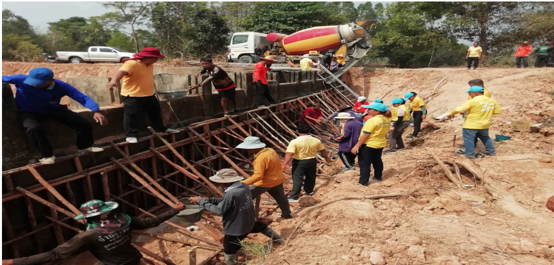
ภาพกิจกรรมโครงการก่อสร้างฝายคั่นดิน บ้านแว้งใหม่ หมู่ 12 ต.ยางสีสุราช อ.ยางสีสุราช จ.มหาสารคาม
